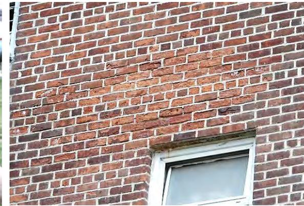
Edificio 2: ladrillo descascarillado en la zona de la bañera
