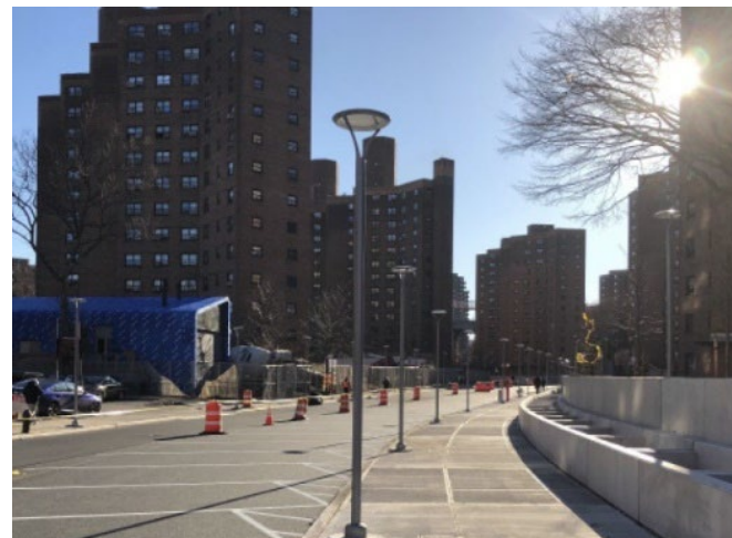
Baruch Drive – bajo construcción
