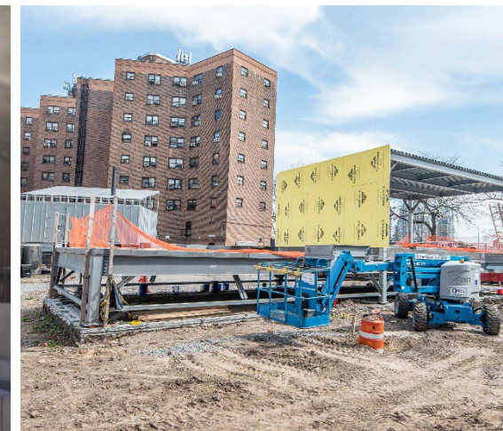
Edificio adicional mecánico eléctrico en construcción
