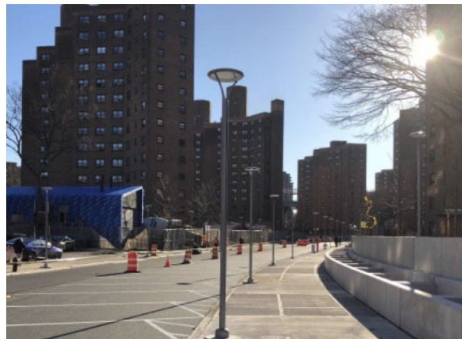
Baruch Drive - 建设中
