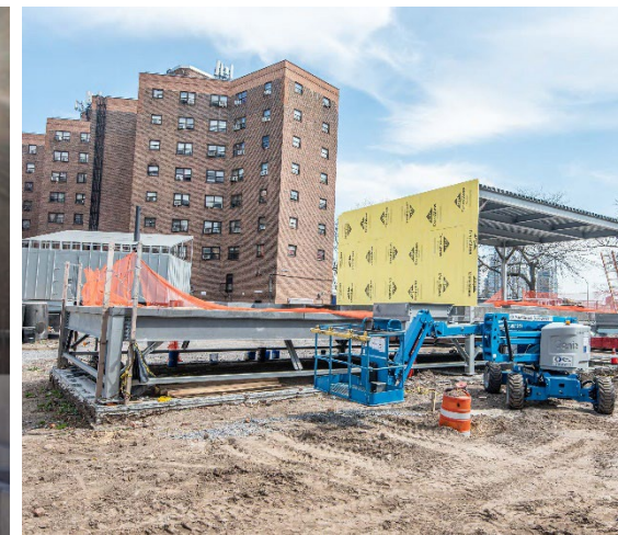
建设中的机电加建大楼
